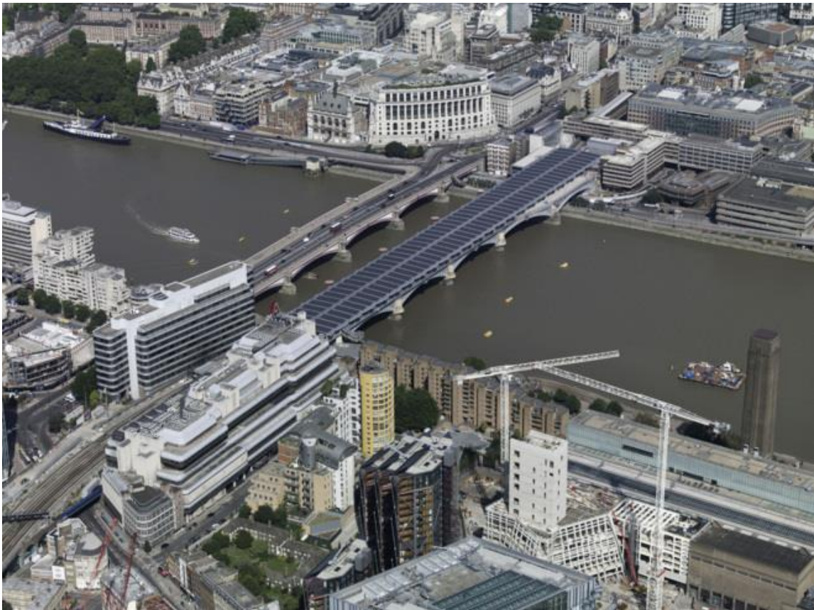
Figura 105. Estación de Blackfriars en Londres, Reino Unido
